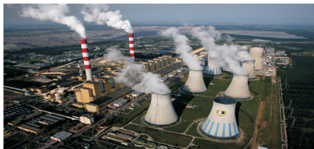
Польшийн 5053 МВт хүчин чадалтай Белхатовын дулааны цахилгаан станц
