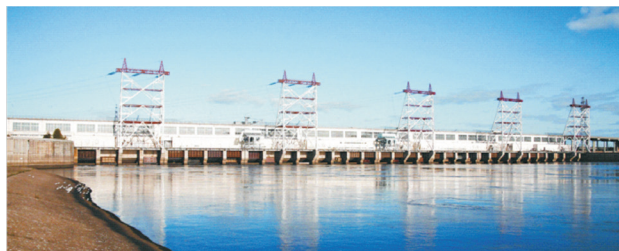
ОХУ-ын 1370 МВт-ын хүчин чадалтай Чебоксарскын усан цахилгаан станц
