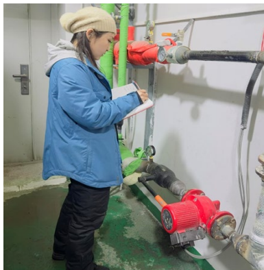
7-р зураг. Халаалтын системийн холигч насосыг эргэлтийн шугам дээр суурилуулсан хэмжилт хийн үзүүлэлт цуглуулж буй байдал
