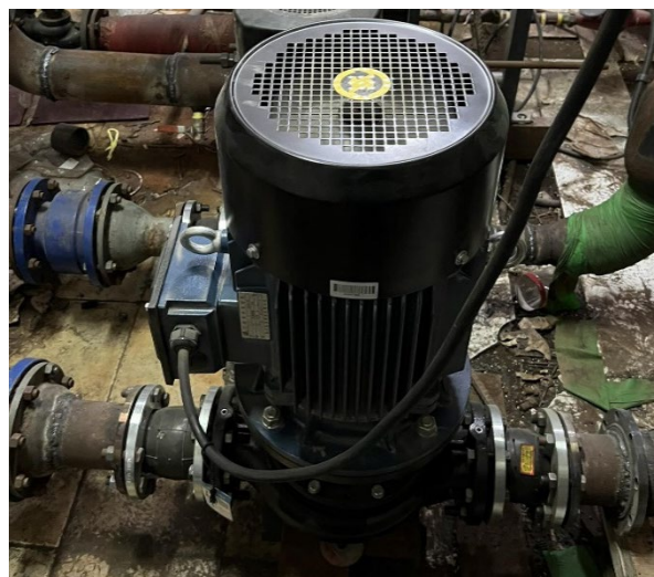
(4-р Зураг насосын сорох болон шахах талд зөөлөн холбоо суурилуулсан байдал)
