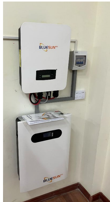
3-р зураг. 304 тоот ангид байрлуулсан хувиргуур болон батерей
