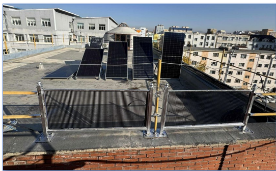
1-р зураг. Дээврийн хашилт хэлбэрээр суурилуулсан CIGS төрлийн нарны цахилгаан үүсгүүрийн харагдах байдал
